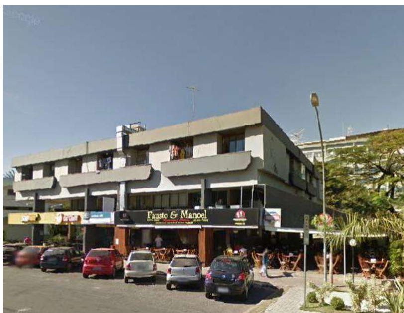
Figura 01 - Edifício comercial localizado na Asa Norte
